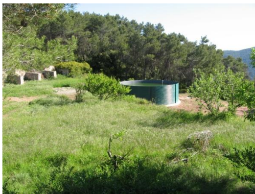
Dipòsit destinat a l'extinció d'incendis. Font: Jordi Catà.
