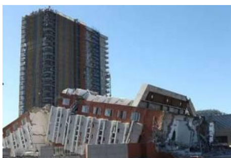
Edifici destruït pel sisme de Xile de l'any 2010. Font: US Geological Survey – USGS ( http://www.usgs.gov )
