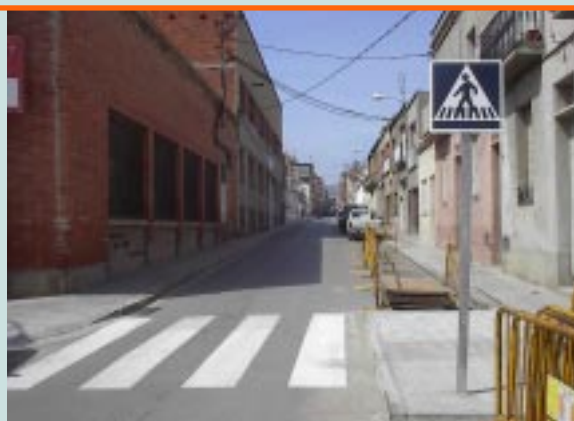
Mostra d'orella a la vorera per recollir l'aparcament
