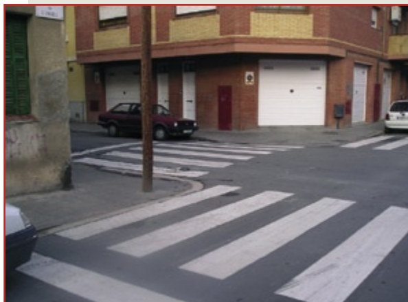
Camp de visió des de la línia de detenció
