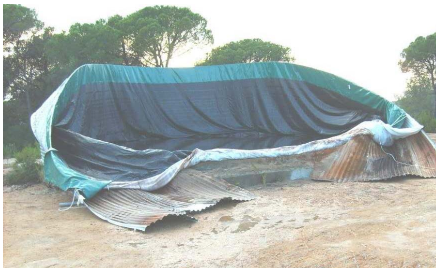
Fig 1.-Punt d'aigua deteriorat per la corrosió de les parets metàl·liques
