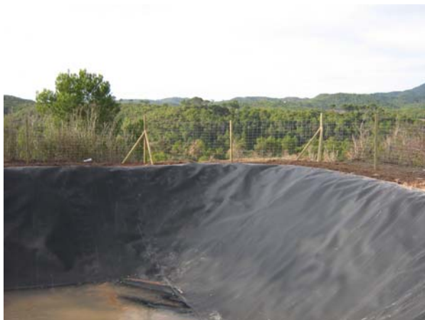
Fig 3.-Punt d'aigua impermeabilitzat amb geomembrana
