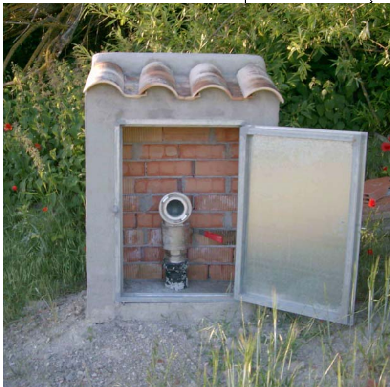
Fig 5.-Armari vertical amb connexió Storz
