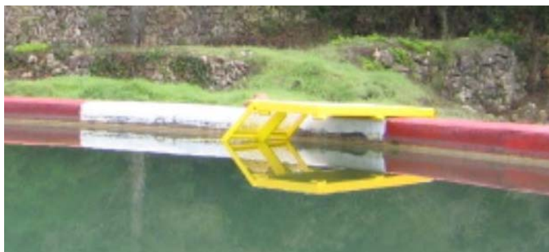
Fig 11.- Rampa de protecció per la fauna
