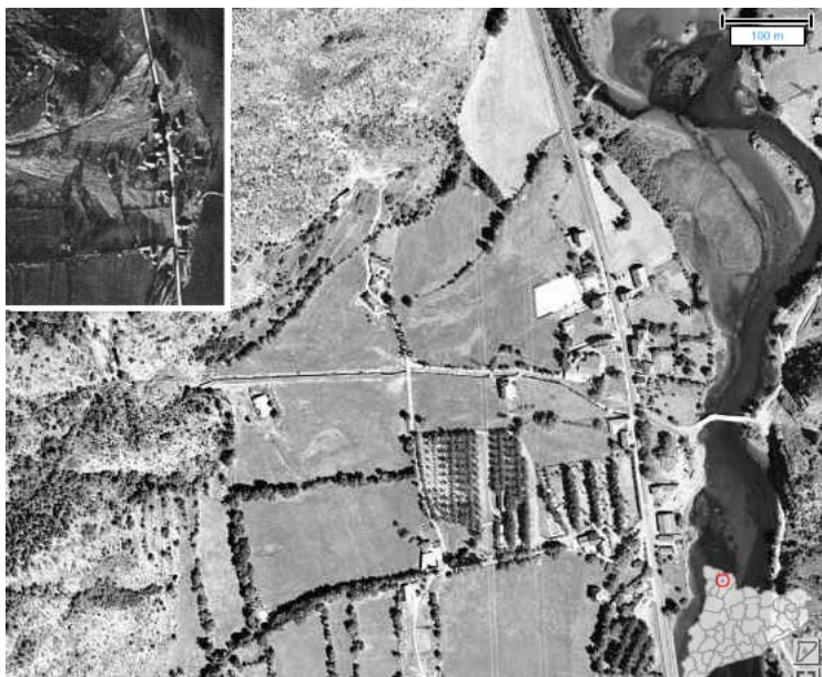
Il·lustració 2.2. Vista en planta poc després dels efectes dels aiguats de l'any 1.982 (fotografia petita) i estat posterior.
