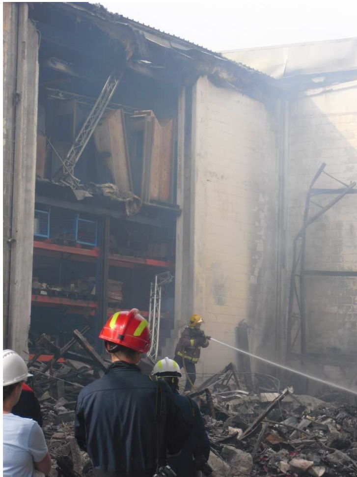
Esfondrament paret mitgera esquerra
