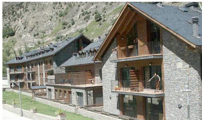
Detall de la proximitat dels ràfecs amb cobertes d'edificacions veïnes
