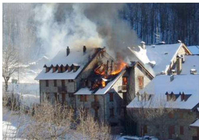
Incendi en una coberta i propagació cap a la coberta veïna Font: Bombers de la Generalitat de Catalunya (cessió d'un particular)
