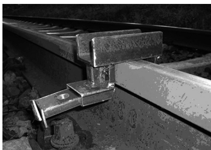
Mecanisme de bloqueig de la via
