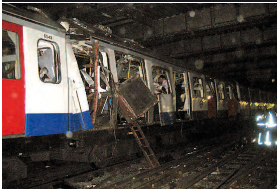
FOTO 4.1. Tren destruït en un túnel (autor: Remco Hendrickx, Flickr)
