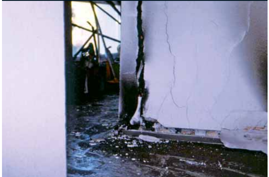
FIGURA 4.18. Trencament de la paret en el recinte d'una escala de l'edifici
