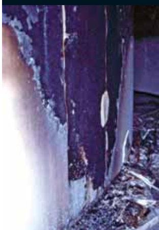
FIGURA 1.11. Marca de V en una paret vertical
