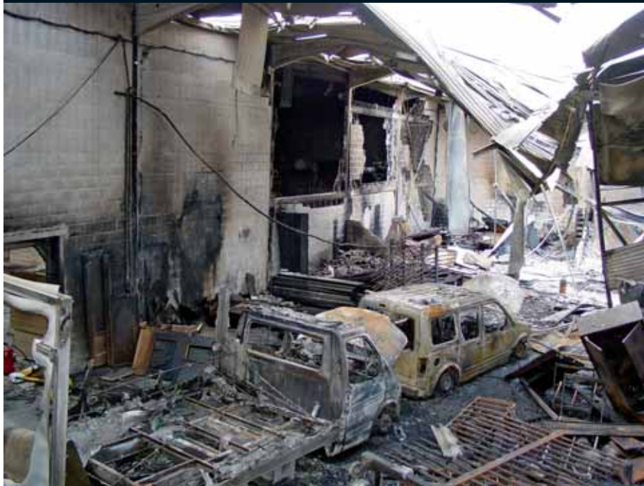
FIGURA 4.10. Interior de la nau de la dreta on es poden veure els dos vehicles afectats per l'incendi
