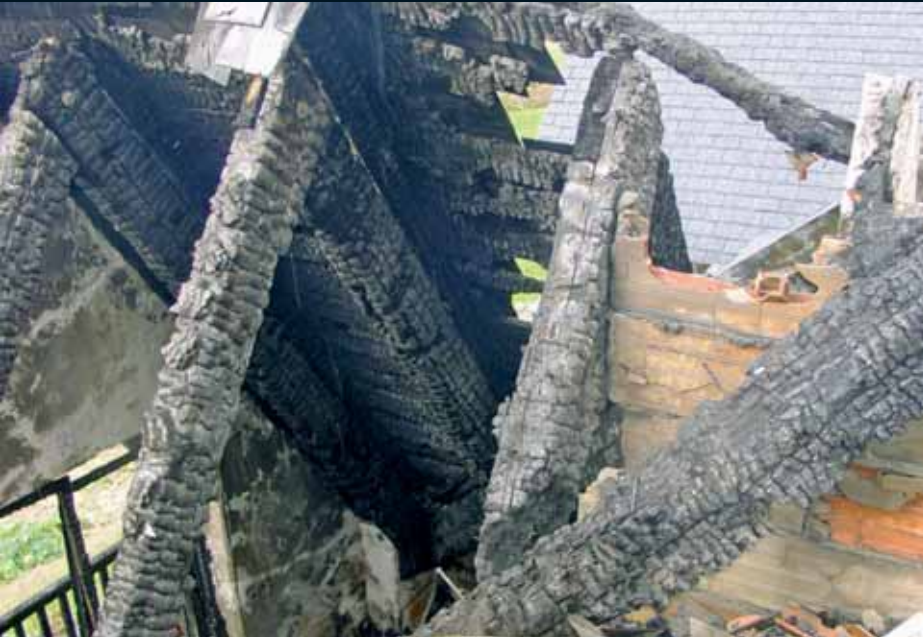
FIGURA 1.8. La fusta carbonitzada presenta un aspecte de 'pell de cocodril'
