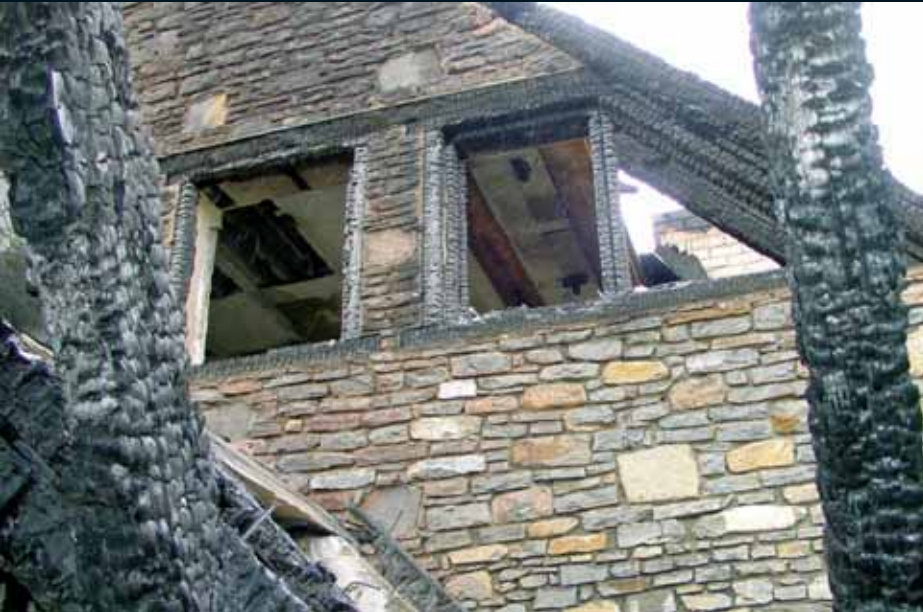
FIGURA 1.7. Fusta carbonitzada
