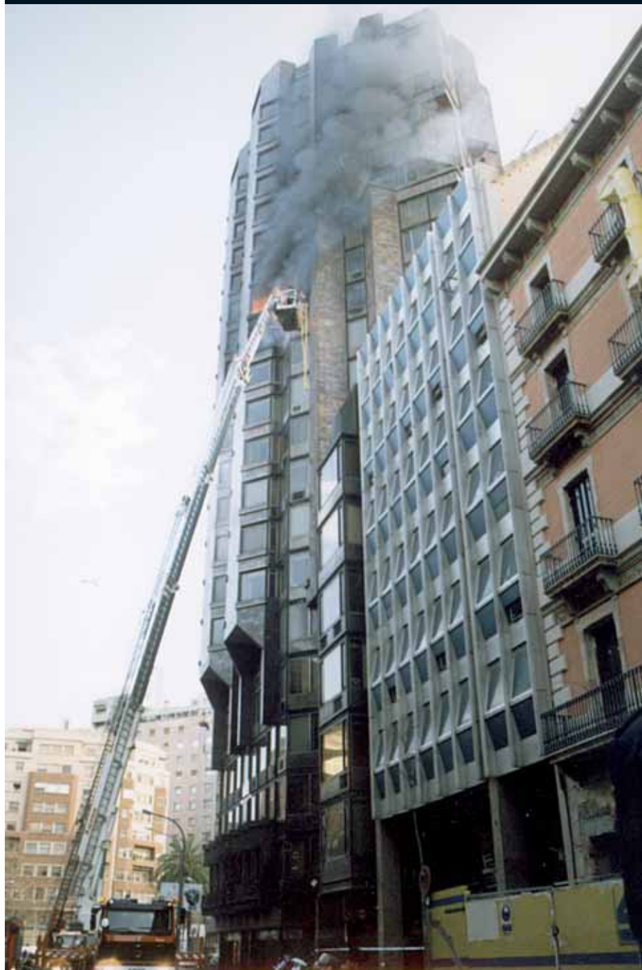
FIGURA 4.1. Vista exterior de l'edifici en el moment de l'extinció
