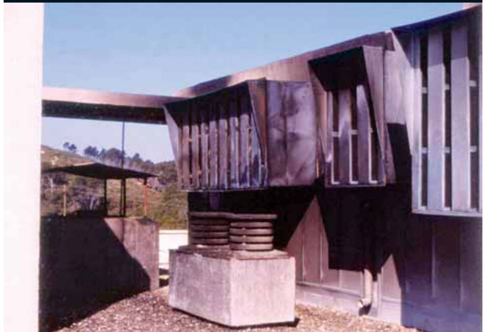
FIGURA 4.19. Coronament del conducte vertical per on van sortir els fums al costat de l'aspiració del climatitzador
