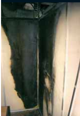
FIGURA 1.12. Marca de con invertit creat per una paperera que va cremar.
