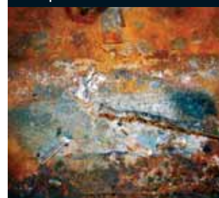
FIGURA 4.22. El cablejat de l'aforador presentava símptomes de curtcircuit
